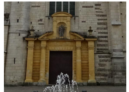
Après nettoyage et pose d'une patine (Église Sainte-Croix de Bernay)
